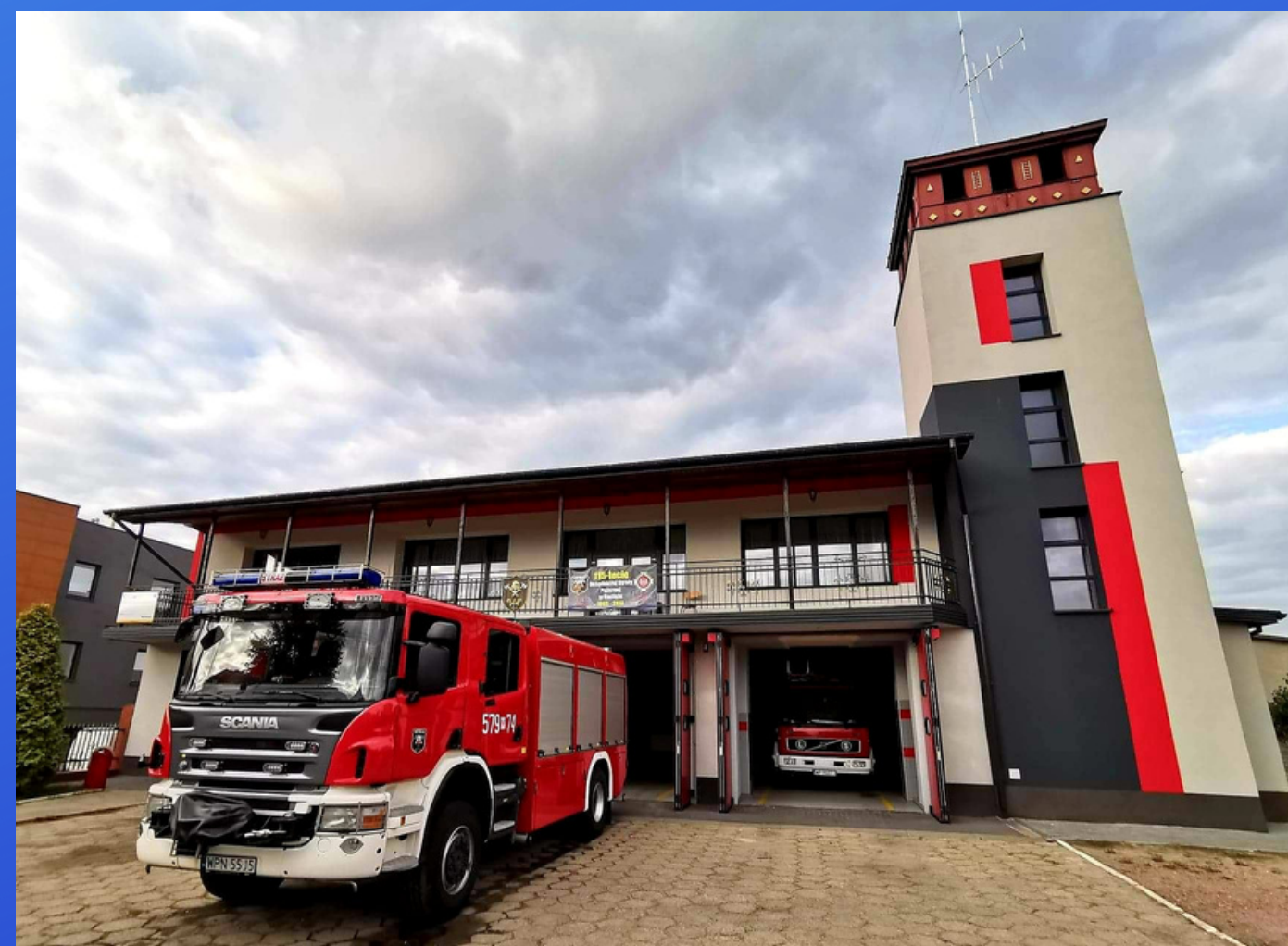
Budynek OSP Raciąż →→
